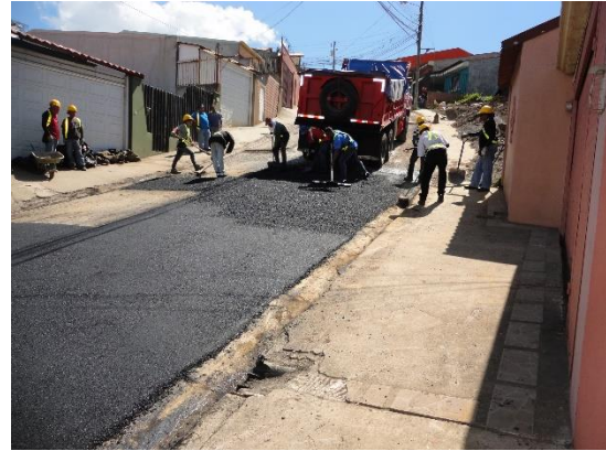
Imagen 6 Colocación de mezcla asfáltica
