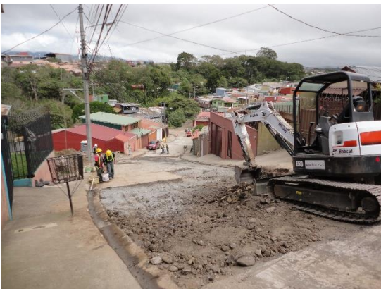
Imagen 2 Preparación de base estabilizada
